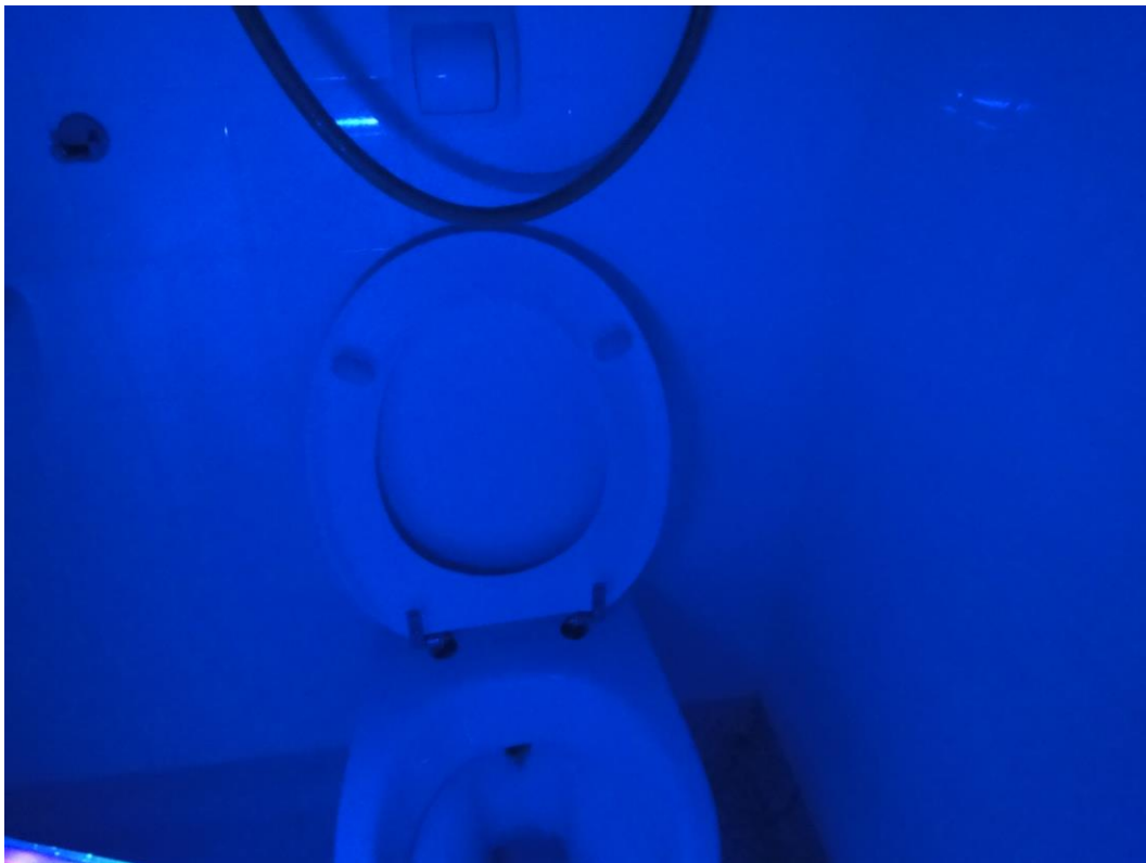
Photo 1 – Témoin, avant rinçage du bassin
